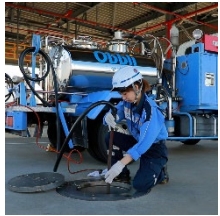
給油設備の 点検業務
